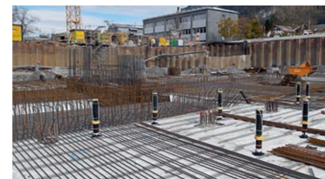
L'armatura può essere messa in posa in modo semplice e senza problemi sopra i fogli Preprufe
