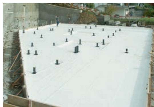
Impermeabilizzazione di un platea con Preprufe
